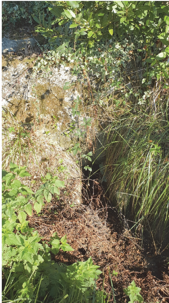
Départ de la conduite depuis le fossé Est de la RD64B
