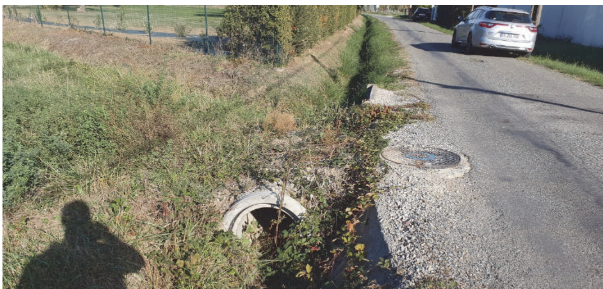
Photographies de la traversée
